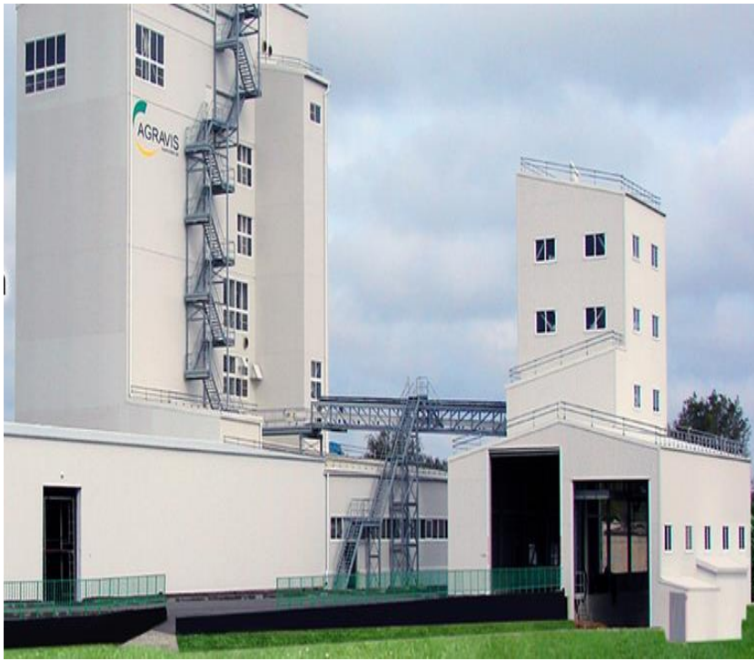
Рис. 39. Комбикормовый завод ООО «Райффайзен Агро» (г. Новоалександровск).
